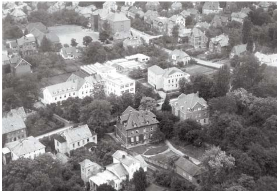
Ausbau von 1930 - „30er Bau“ mit Flachdach
