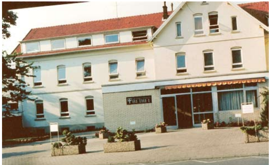
Aufnahmepavillon mit Telefonzentrale
