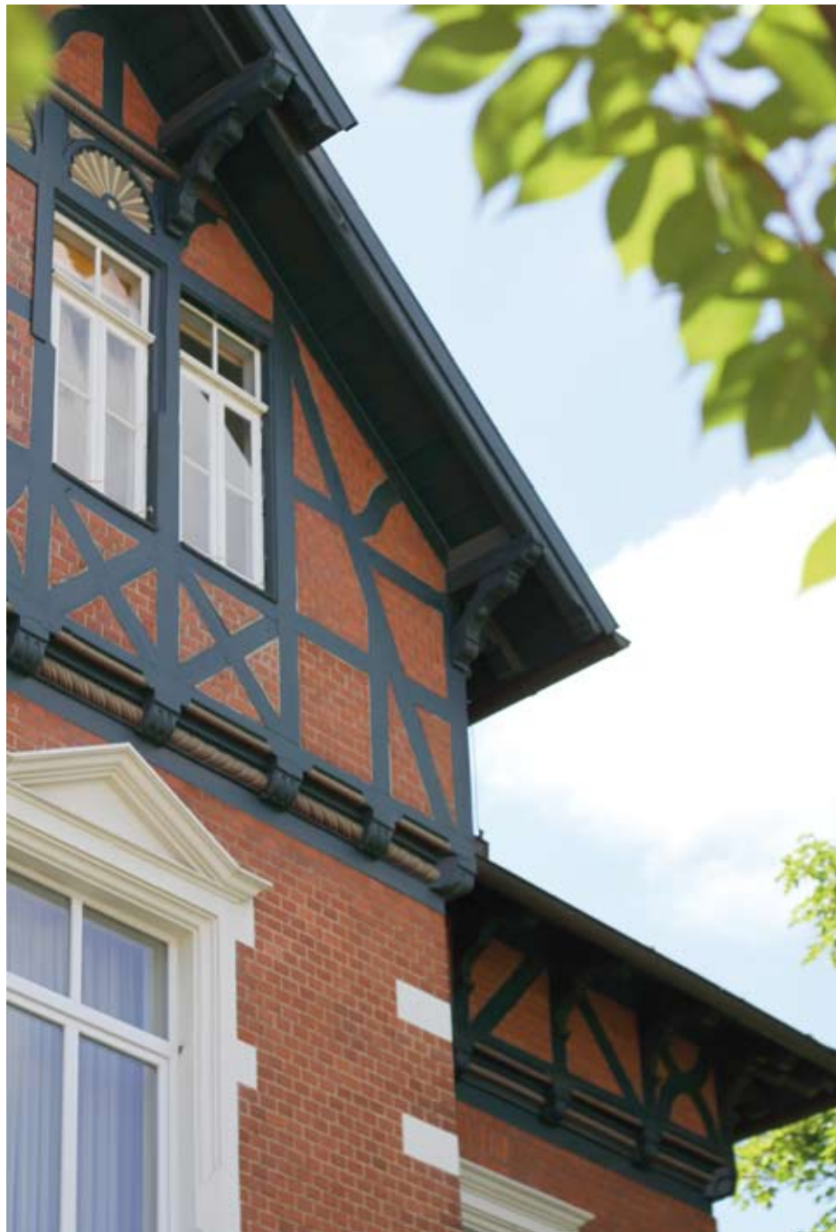
Fassade des Verwaltungsgebäudes, welches Ende der 50er Jahre angekauft wurde
