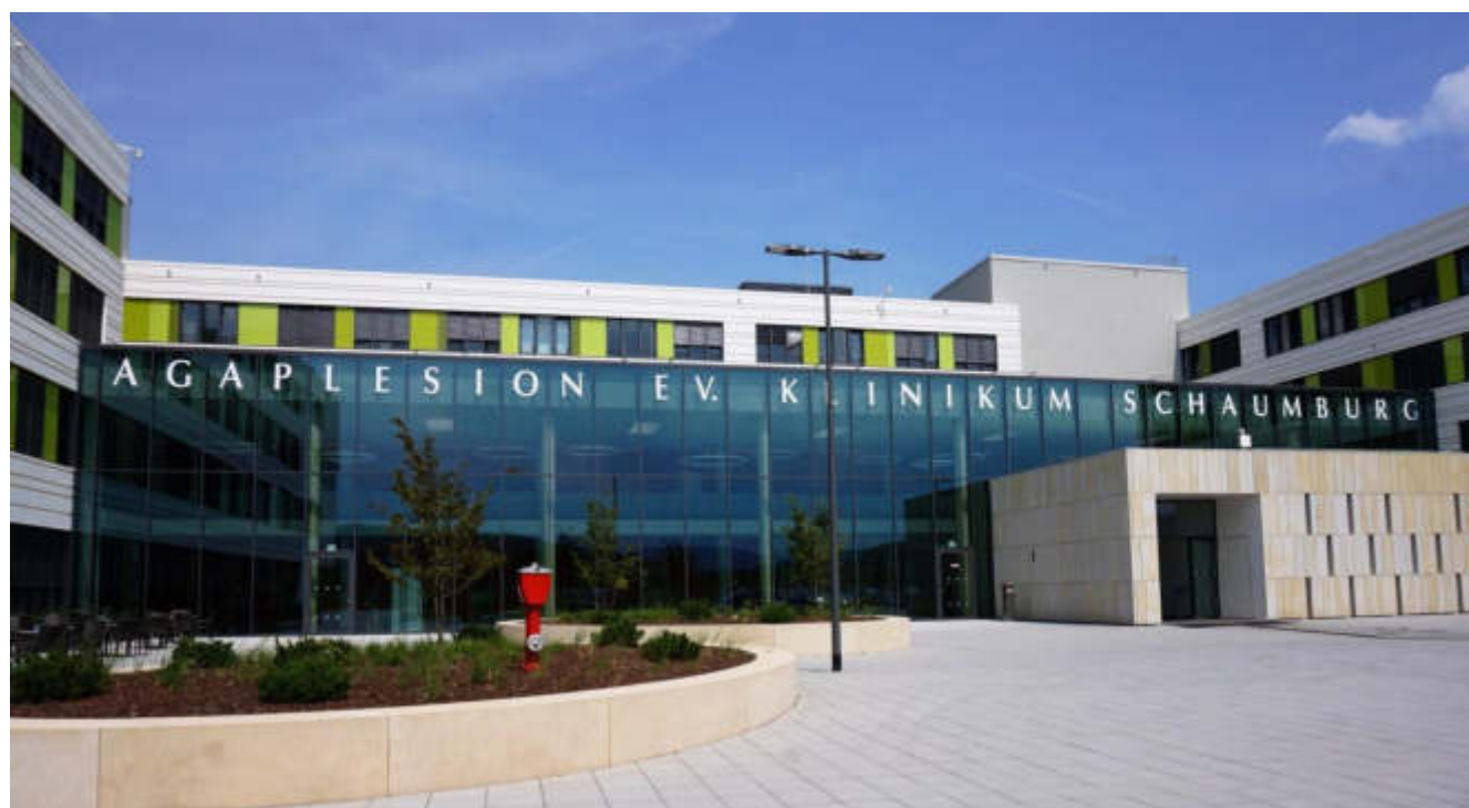
Frontansicht AGAPLESION EV. KLINIKUM SCHAUMBURG gGmbH
